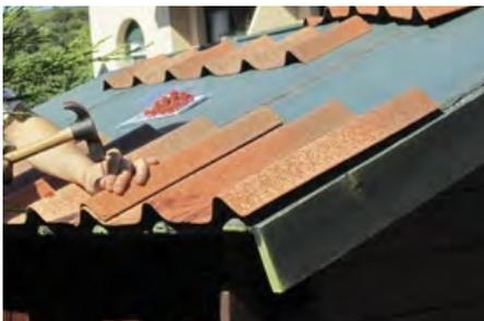
Colocar la **primera fila de tejas** solapando lateralmente y fijando a través de la parte alta de las ondas. **Dejar sin fijar las ondas de ambos extremos.** El vuelo máximo de ONDUVILLA® sobre el alero será de 5 cm.
