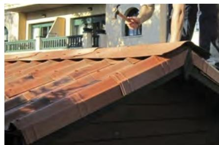
Colocar las piezas de cumbrera ONDUVILLA® **solapándolas un mínimo de 3cm** y fijándolas a través de la parte alta de las ondas.
